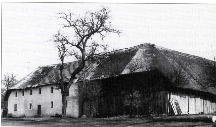
Ein weiterer Vierkanthof ist das Bauernhaus „Unter-Eben“ in St. Leonhard am Walde Nr. 45. In diesem Ortsteil gibt es nur eine äußerst geringe Anzahl von Höfen dieser Art. Die Eindeckung mit Stroh wurde teilweise schon aufgegeben, völlig mit Ziegel umgedeckt wurde 1960/61. – Aufnahme: Mai 1955
